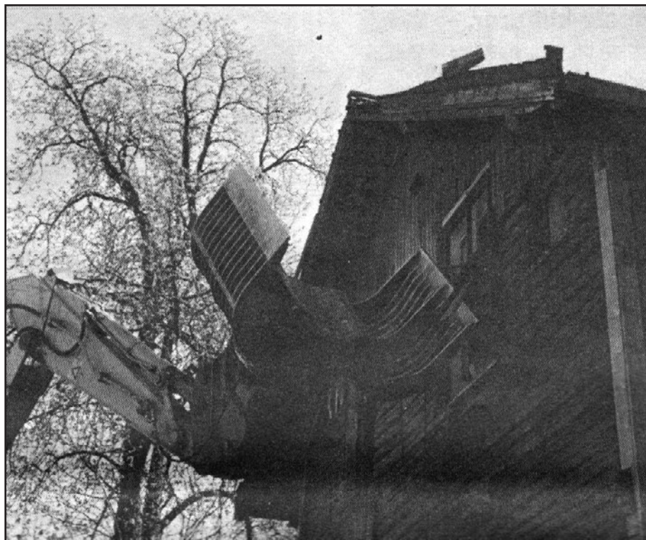
Tømmerhuset i Holmboesgate blir brutalt brutt sammen, bit for bit, av en kjekk gravemaskin.
